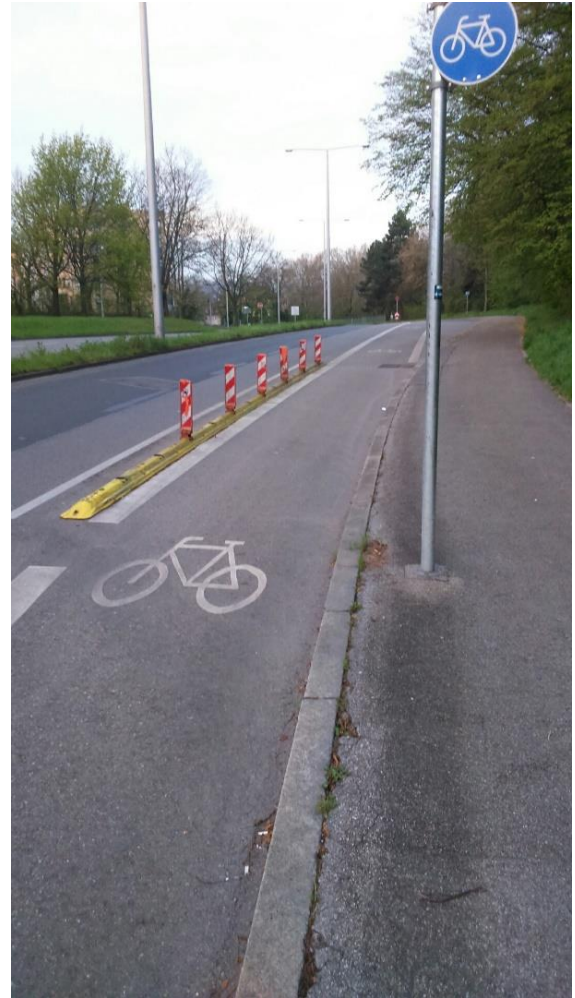
Bild 2: Sicherung Radspur Höhe Gnesenerstraße 44 Bad Cannstatt
